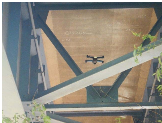
全方向衝突回避センサーを有する小型ドローン技術（BR010009-V0121）による点検状況
