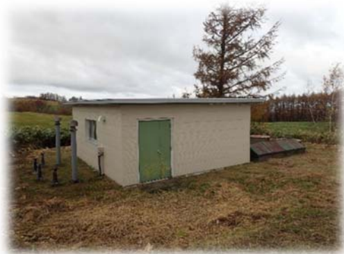
東藻琴東洋配水池
