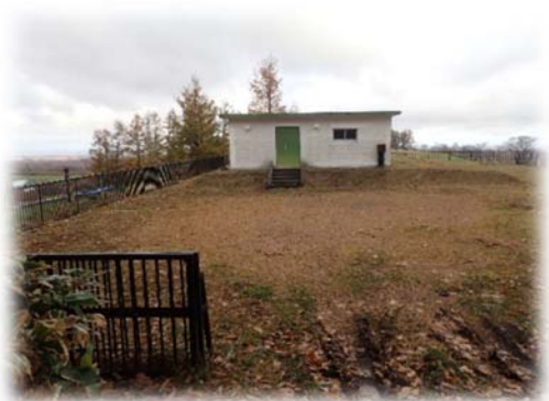
東藻琴高区配水池
