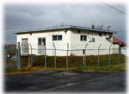
東部高台配水池、配水ポンプ場
