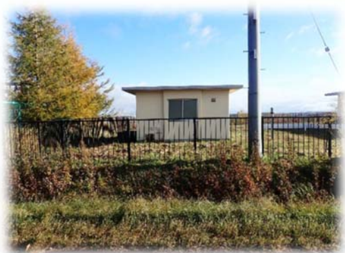
東藻琴福富配水池
