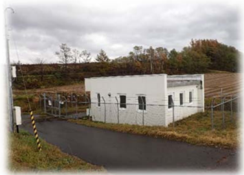
大成導水ポンプ場
