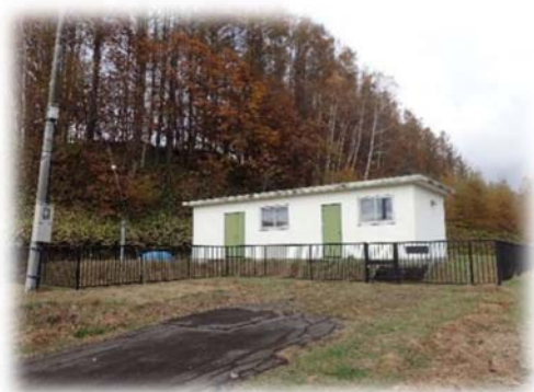
東藻琴低区配水池
