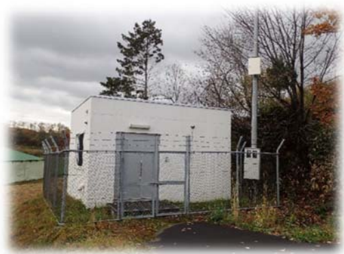
豊住ポンプ場
