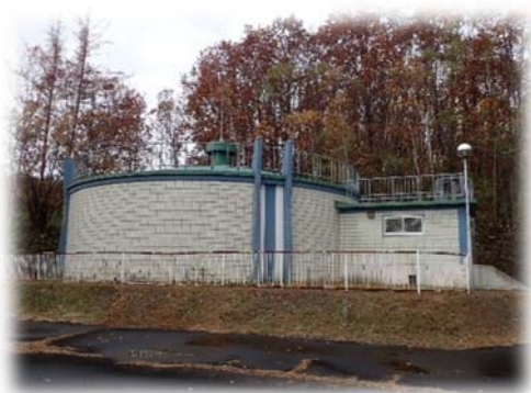
東藻琴配水池
