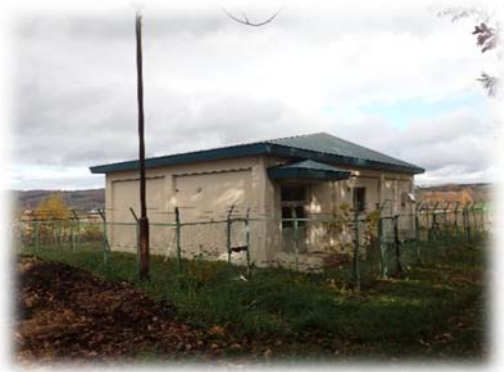
湖南送水ポンプ場
