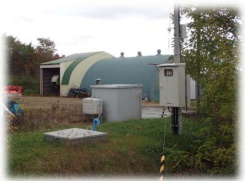
豊里ポンプ場
