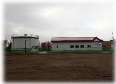
大成浄水場、配水池
