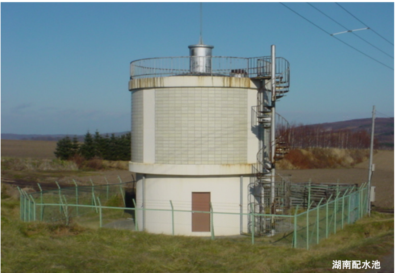
東部高台浄水場
