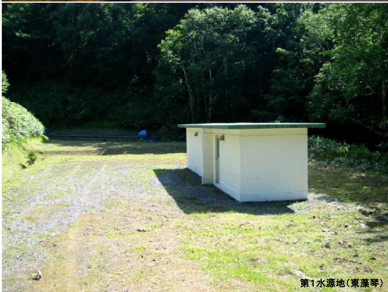
東部高台配水池
