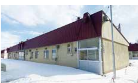
用途廃止となった公園公住
