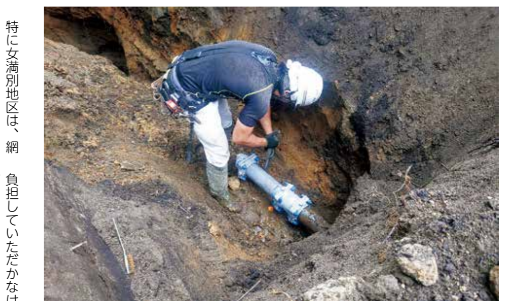
漏水復旧作業
