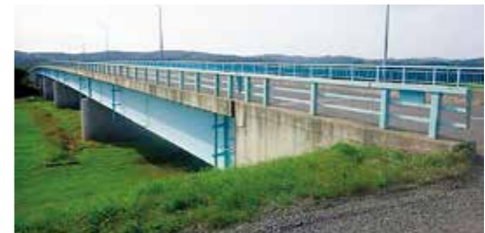
補修工事を行う豊郷橋
