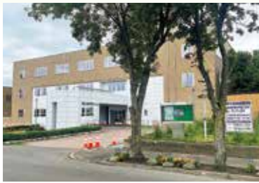
外構工事中の役場庁舎
