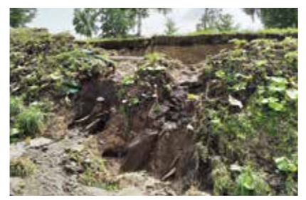
大雨の被害を受けた芝桜公園（法面）
