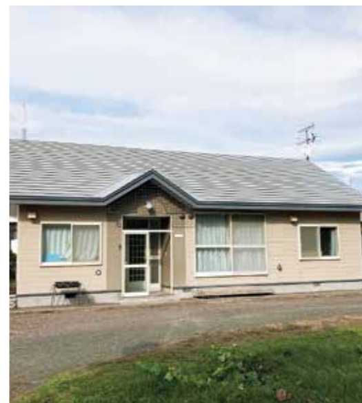
既存の教員住宅
