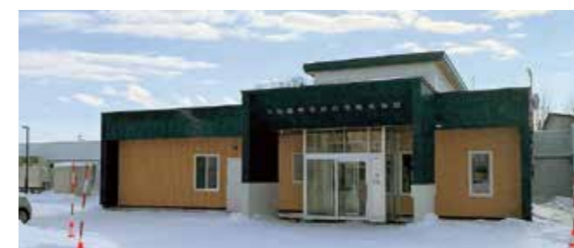
建設中の交流拠点施設
