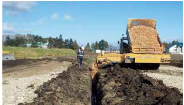
暗渠排水施工中の農地
