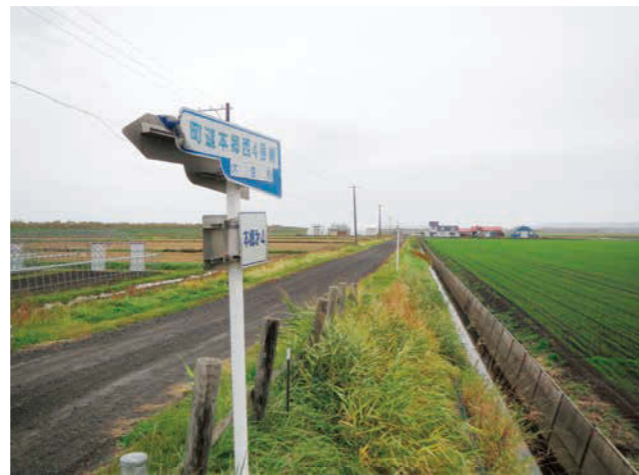
舗装工事がなされる本郷西4号北線
