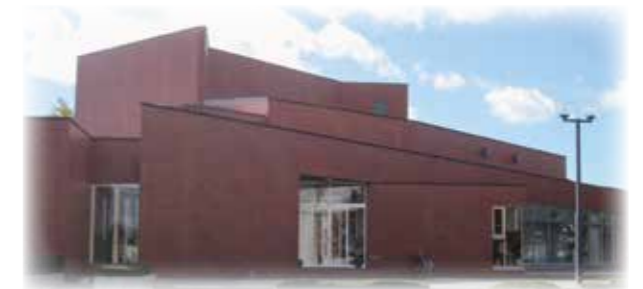
【教育文化会館】町の文化活動の拠点であり、多くの方が使用する施設として安全対策が必要
