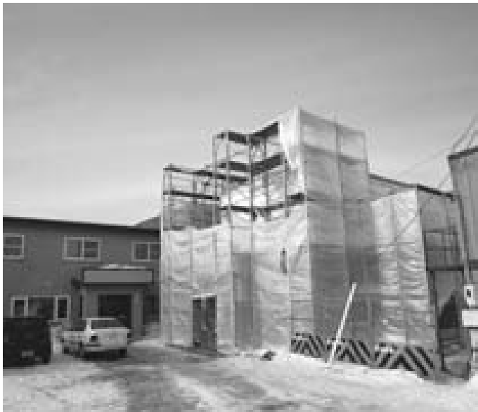
寄宿舍建設工事現場の風景
