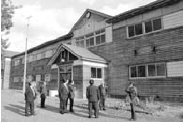
道内最古の木造建築「増毛小学校」
