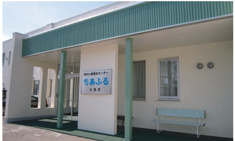
大空町の障がい者福祉の拠点施設ともいえるべき「障がい者福祉センターちあふる」が整備されました。平成24年4月から供用開始となっています。
