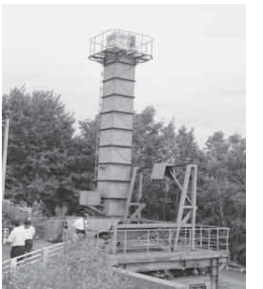
解体予定の最終処分場焼却炉
