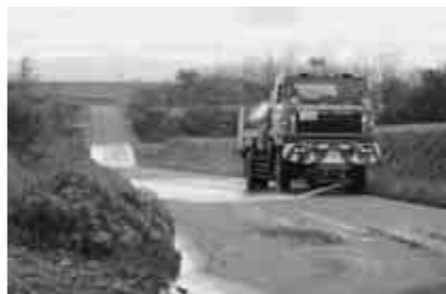
道路維持作業状況
