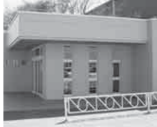
いこいの広場公衆トイレ
