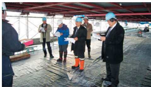
開陽中央線道路（橋梁上部工）現場を、産業建設文教常任委員会で視察
