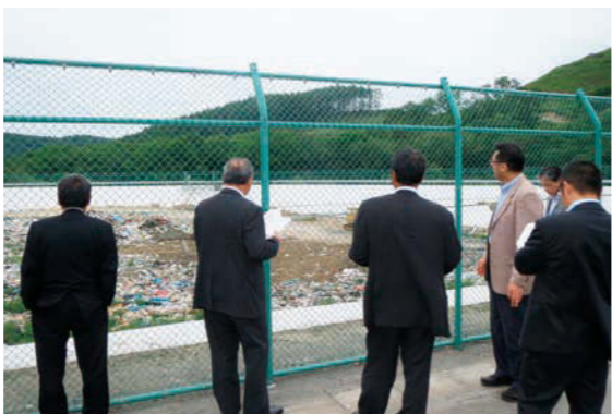
長く施設を利用するため、さまざまな措置がなされる、一般廃棄物最終処分場
