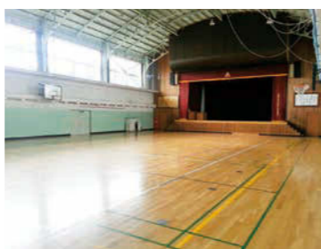
今回耐力度調査を行う東藻琴小学校の体育館
