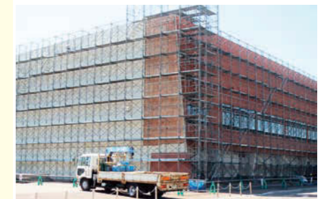
改修が始まったゲートボールセンター
