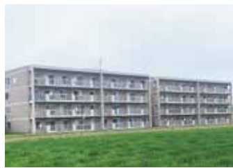
令和4年度に工事を行うはなぞの団地
