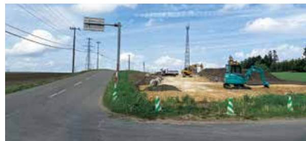
改良工事が進む開陽中央線
