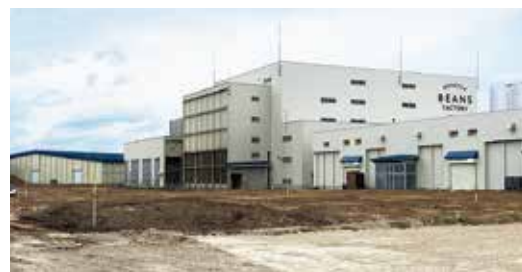
施設を増設するビーンズファクトリー
