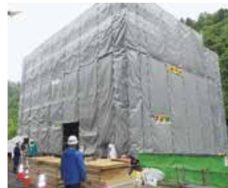
建設中の小水力発電施設
