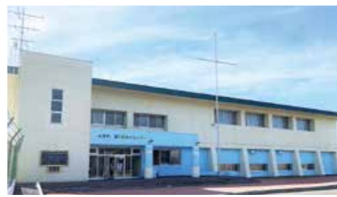
多機能化工事を実施する海洋センター
