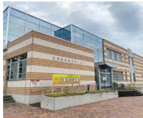
平成元年建設の農業構造改善センター
