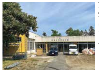
解体される女満別幼稚園
