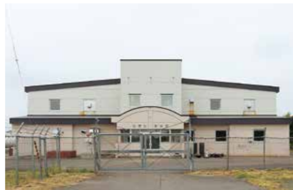
市街、低台、湖南地区に水道水を供給する昭和浄水場
