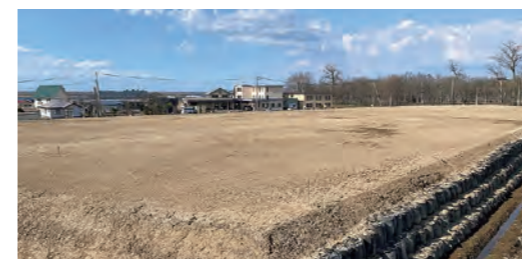
土盛りされた河川防災ステーション建設用地
