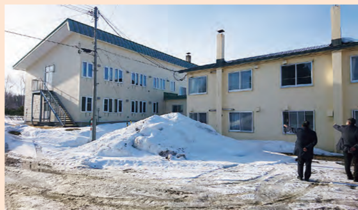
築35年が経過した増築棟(写真左側) 【東藻琴寄宿舎】
