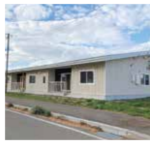
空室となっている町営住宅
