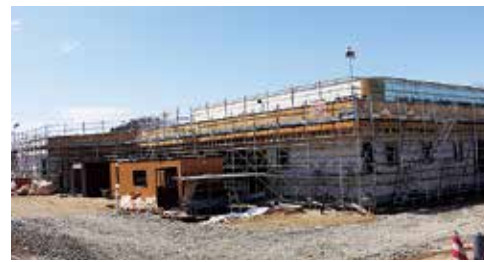
建設中の認定こども園（女満別地区）
