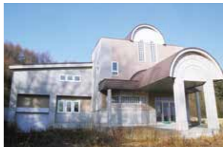
建設が途中で中止の医薬関係の試験研究施設
