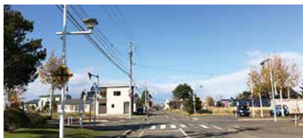
白く再塗装された東藻琴8号線の街灯
