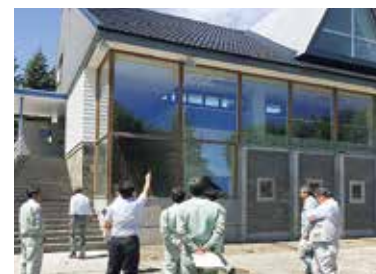
改修工事は来年3月に完成
