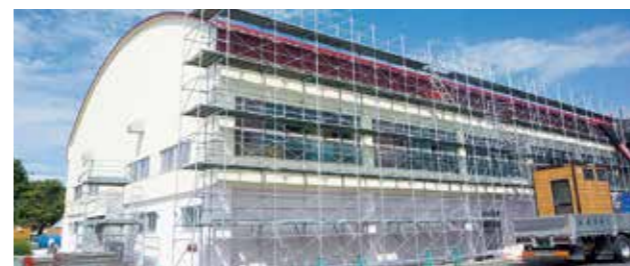
女満別中学校改修工事の様子
