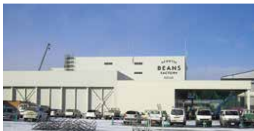
広域穀類乾燥調製貯蔵施設
