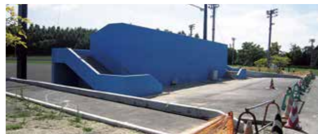
女満別運動公園野球場改修現場
