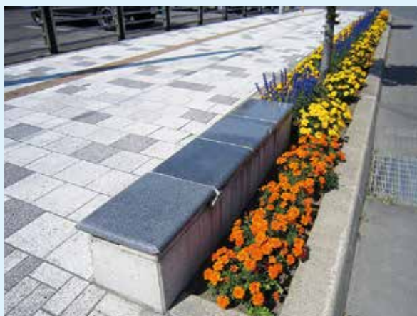
空港線ベンチの状況
