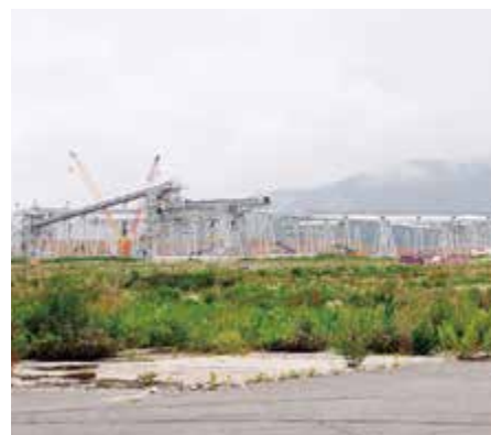
かさ上げ用の土を運ぶベルトコンベヤー
