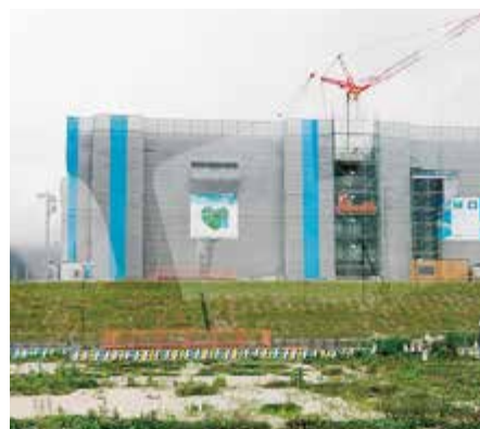
かさ上げして建設中の公営住宅
