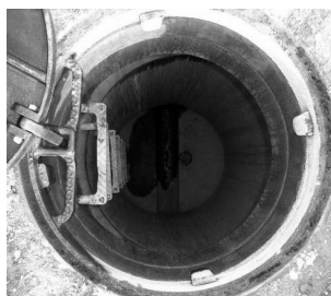
きれいなマンホール
