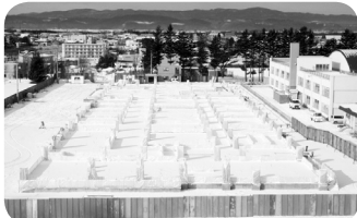
工事現場風景(基礎敷設工事終了)
