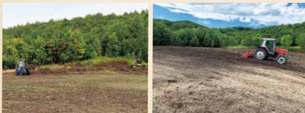
整備作業の様子 重機で伐根(ばっこん)し、除草や整地等を行い、事業実施に向け準備を進めています。
