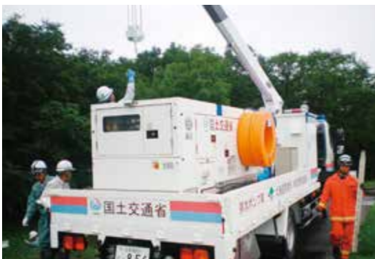
ポンプ車による排水(国土交通省・網走開発建設部)
