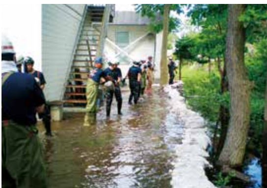
湖畔民家前土のう作業の様子
