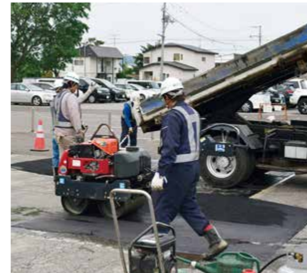
駐車場破損箇所の補修
