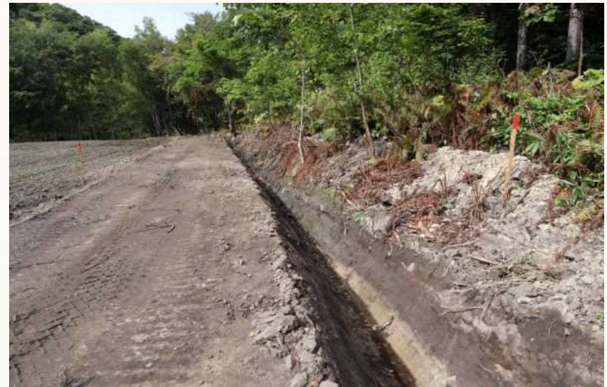
側溝整備（現在も随時実施）
