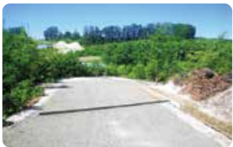
耕作道排水整備施工
