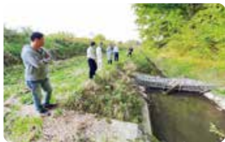
特殊沈砂池施工
